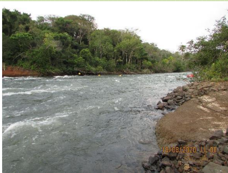
Figura 7. Trecho a jusante do barramento na campanha de agosto de 2020 no monitoramento de comunidades aquáticas na PCH Verde 4A.
